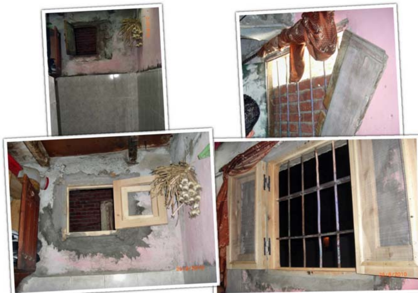
Bilder oben: alte verrottete Fenster, unten: neu eingebaute Fenster
